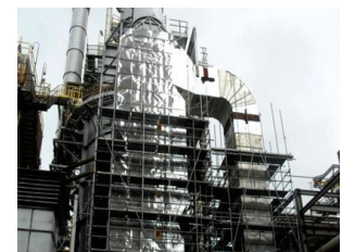
AIR PREHEATER 설치
